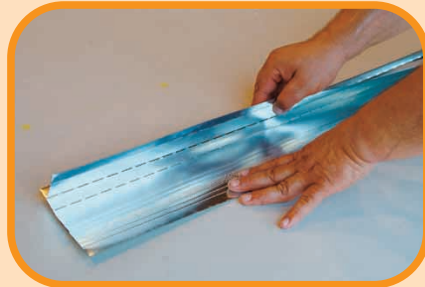
Sollevare l'aletta del profilo e posizionare l'asola dell'aletta larga in corrispondenza della quota di imposta.
