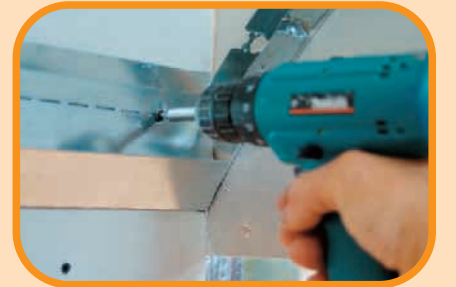
Piegare il profilo fino a raggiungere l'angolo di curvatura di progetto. Fissare con viti finta rondella le due alette mantenendo l'allineamento sfruttando la puntatura parallela.
