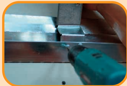
Fissaggio del profilo T-plan + giunto lineare piegato a "Z" sul profilo rigido ad angolo variabile.
