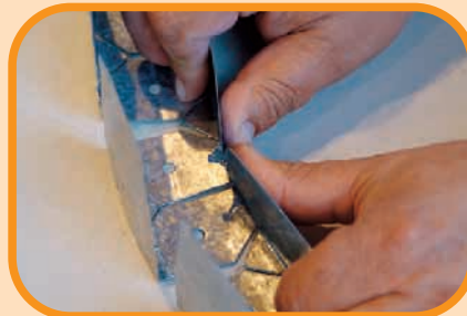
Per curvare il profilo GA basta una semplice pressione dei pollici sui naselli.
