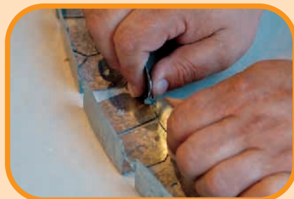
Con una leggera pressione esercitata dai pollici sui naselli, si ottiene un profilo rigido con il raggio di curvatura desiderato.
