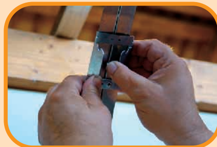
Inserimento accessorio per lo scatto. Il posizionamento è facilitato dallo scorrimento dell'accessorio lungo le ali.
