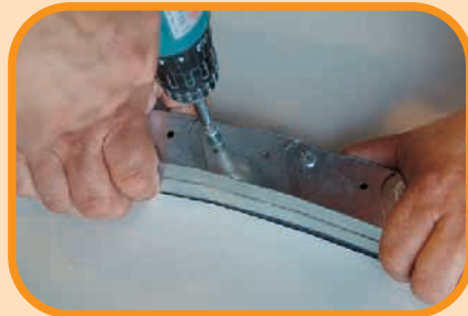
Grazie ad una serie di prefori, il profilo si blocca lungo la curva di progetto semplicemente con delle viti finta rondella.
