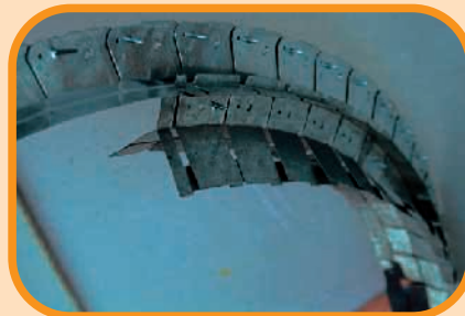
Le alette del profilo L2D vanno sagomate secondo la curvatura di arrivo dei secondari 50/27. La struttura così formata si posiziona lungo le diagonali.
