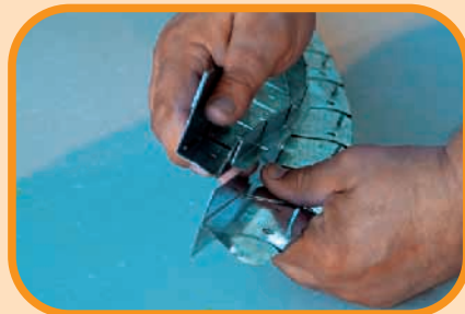
Negli incroci di volta si utilizzano, accoppiati, 2 profili L2D e 1 profilo T-plan. Si inseriscono sulle alette piane del profilo T-plan due profili L2D le cui alette inclinabili costituiranno la base di appoggio dei profili 50/27 secondari.
